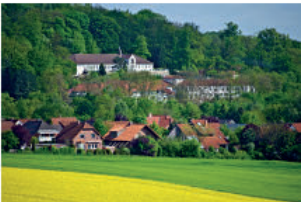
FOTO: GEMEINDE DIEKHÖLZEN
