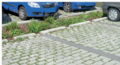
Abb. 49 - Wasserdurchlässige Belag auf Parkplatz in Kombination mit Versickerungsbetten [10]
