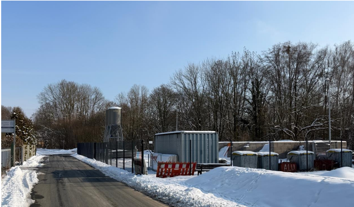
Abb. 2: Salzsilos mit einer Höhe von rd. 11,30 m am Hildesiaweg (Gemeinde Diekholzen, 02/2026)
